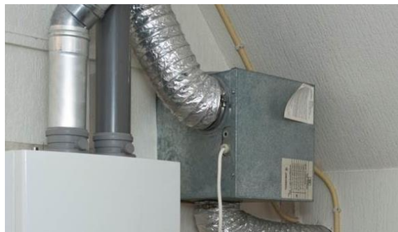
Ventilatiebox vervangen
