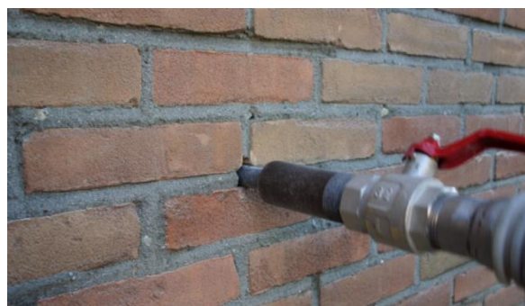
Spouwmuurisolatie
