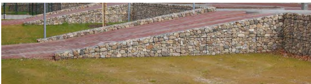
Grondkering met schanskorven
