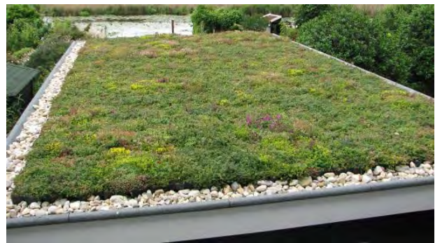
Sedumdak voor carport
